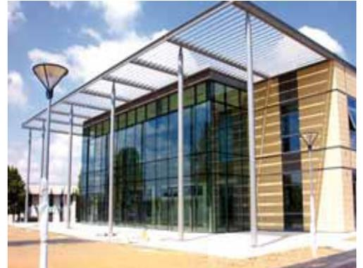
Les lames sont fixées mécaniquement par flasques entre les profils consoles.
